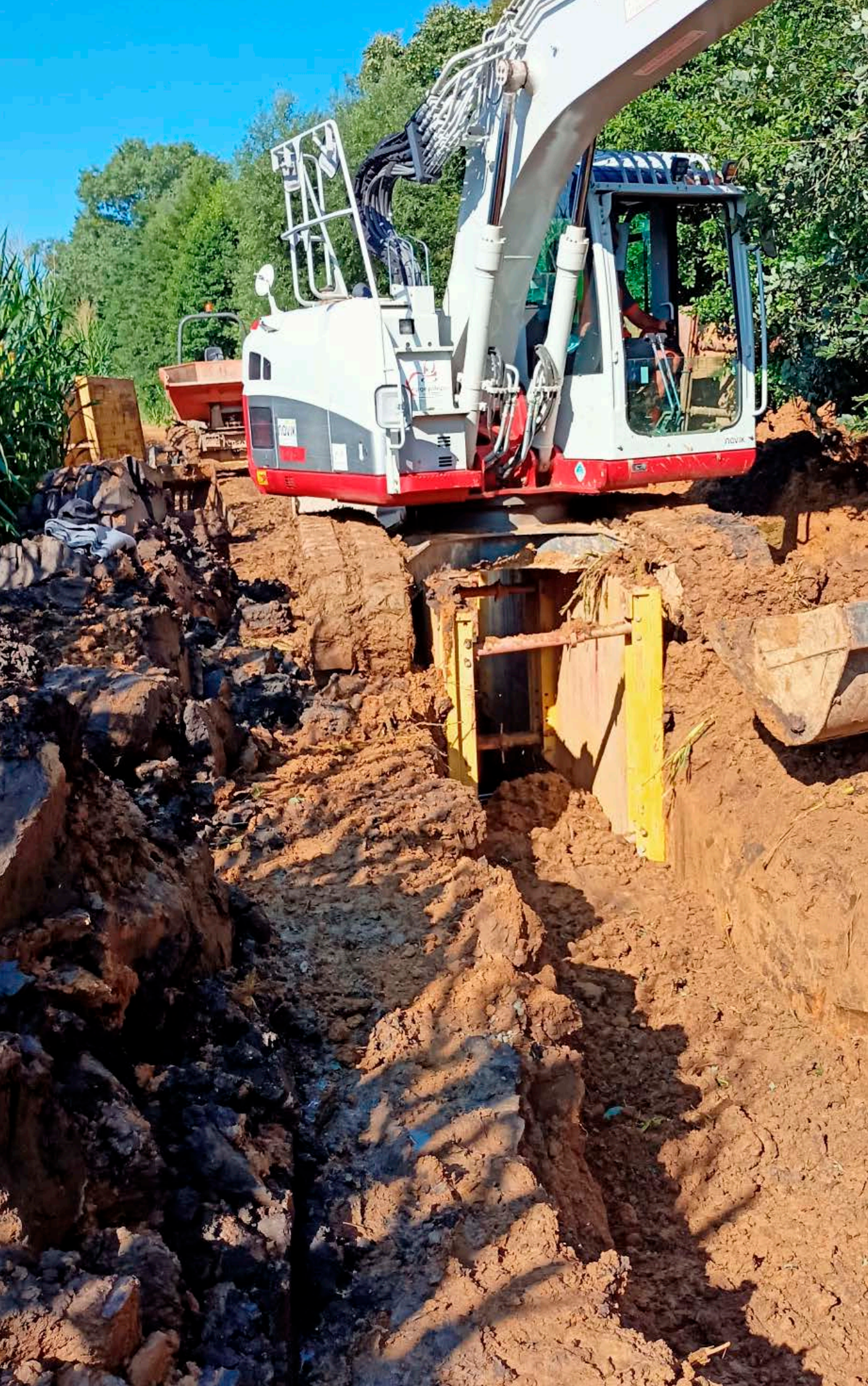
↓ Odkanalizování místní části Újezd - Mohelnice
