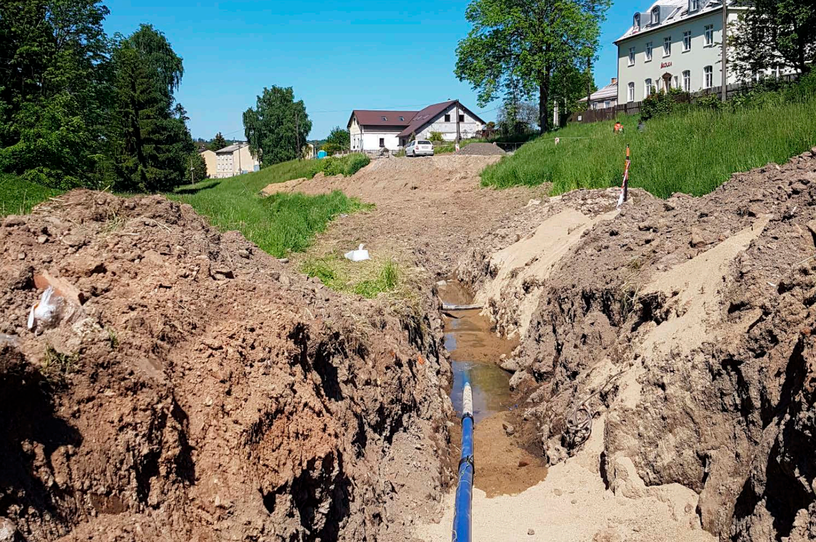
↑ Stavební úprava a přeložky vodovodu Maletín
