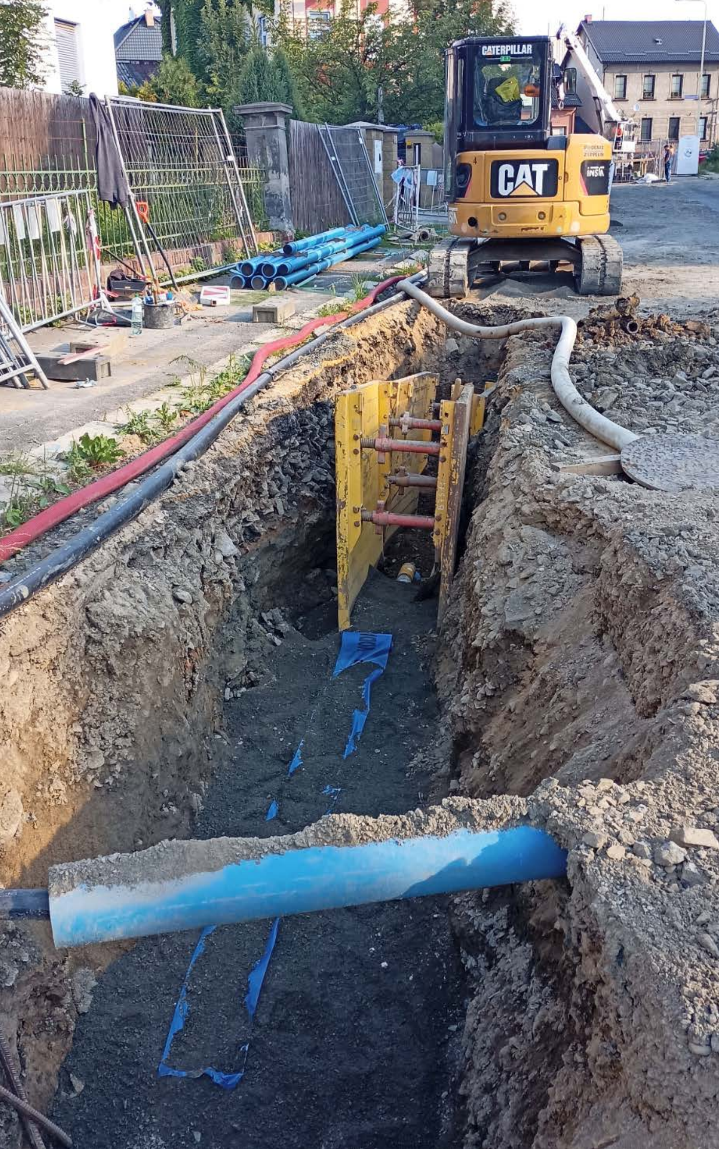
↴ Rekonstrukce vodovodu a kanalizace ul. B. Němcové, Nemocniční a Luční
