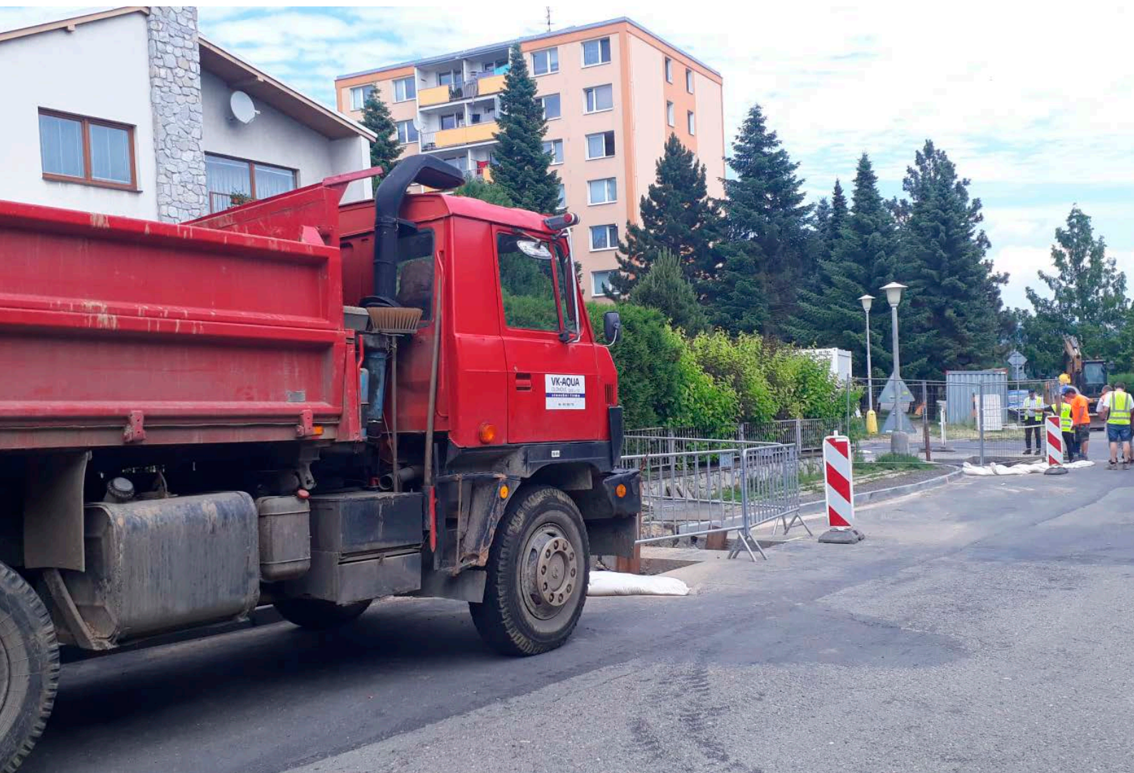
↓ Stavební úprava vodovodu Na Výsluní a M. Vizovské, Zábřeh
